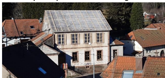
Charpente provisoire et bâchage.
